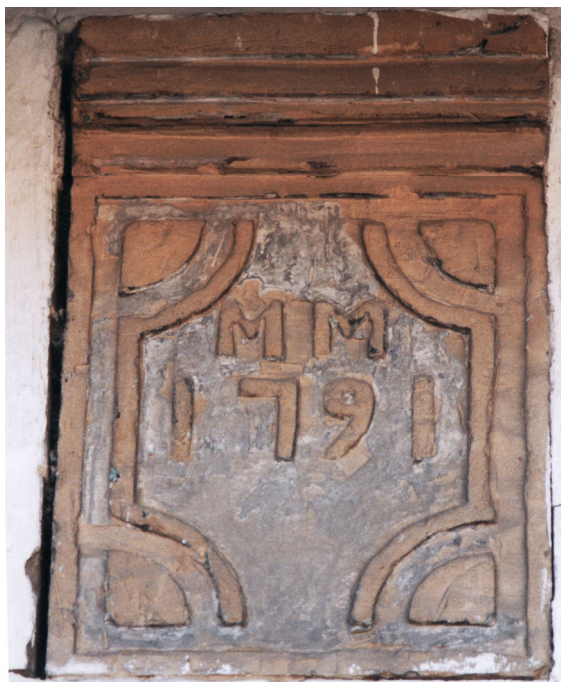
De gevelsteen uit 1791 met de initialen M M.
